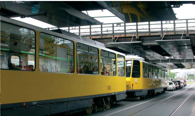
Eisenbahnüberführungen Rudower Chaussee
