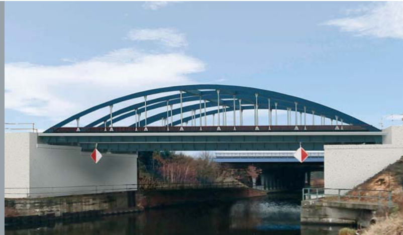
Entwurf Teltowkanalbrücke – Bauart Stabbogenbrücke
