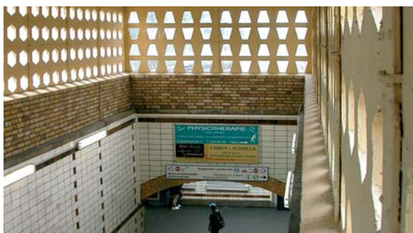
Blick vom S-Bahnsteig in die Bahnhofshalle
