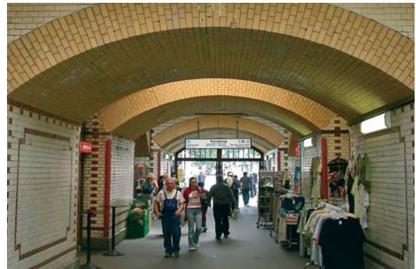
Zugangsbereich zu den S-Bahnsteigen
