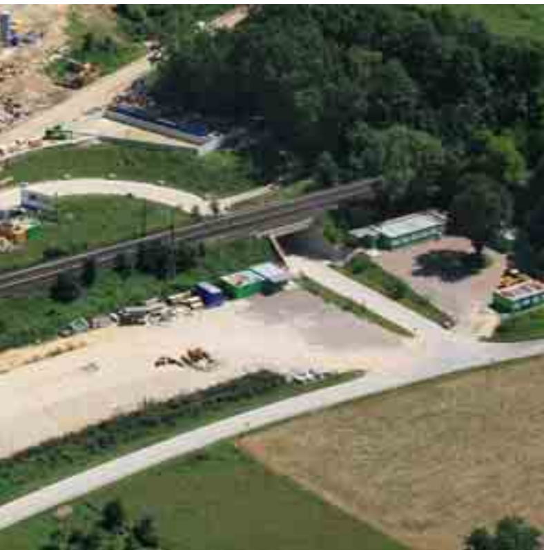
Eisenbahnüberführung nördlich des Katzenbergtunnels
