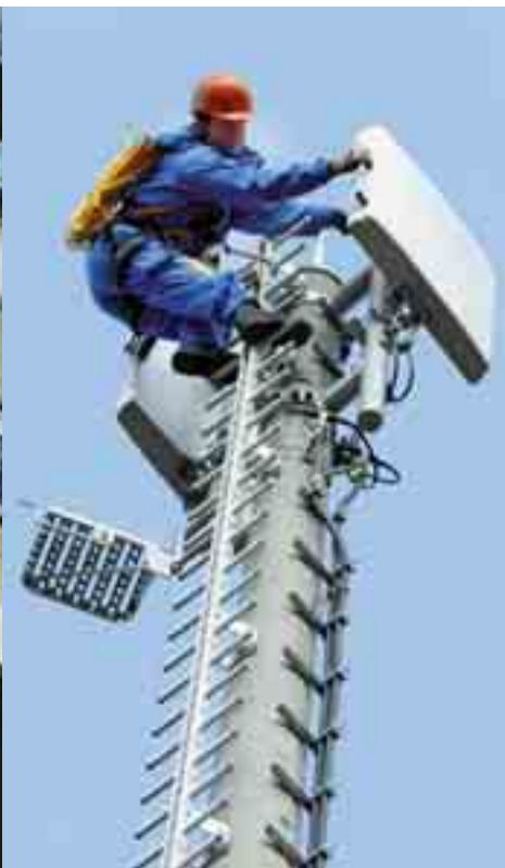
Sendemast für das digitale Mobilfunknetz GSM-R
