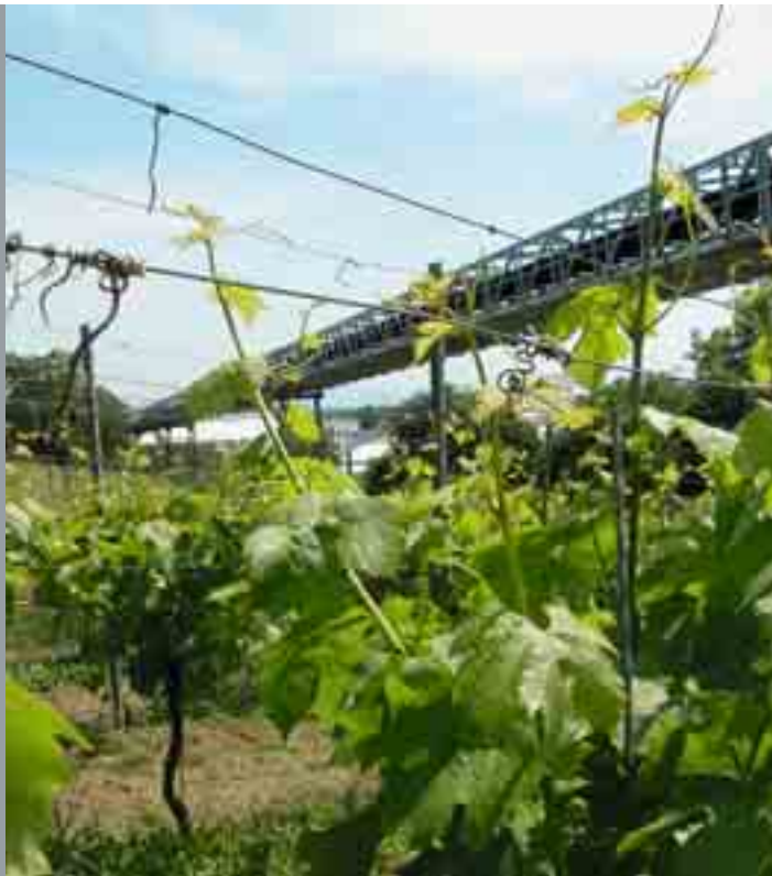
Ein Förderband transportiert den Aushub des Katzenbergtunnels umweltschonend ...
