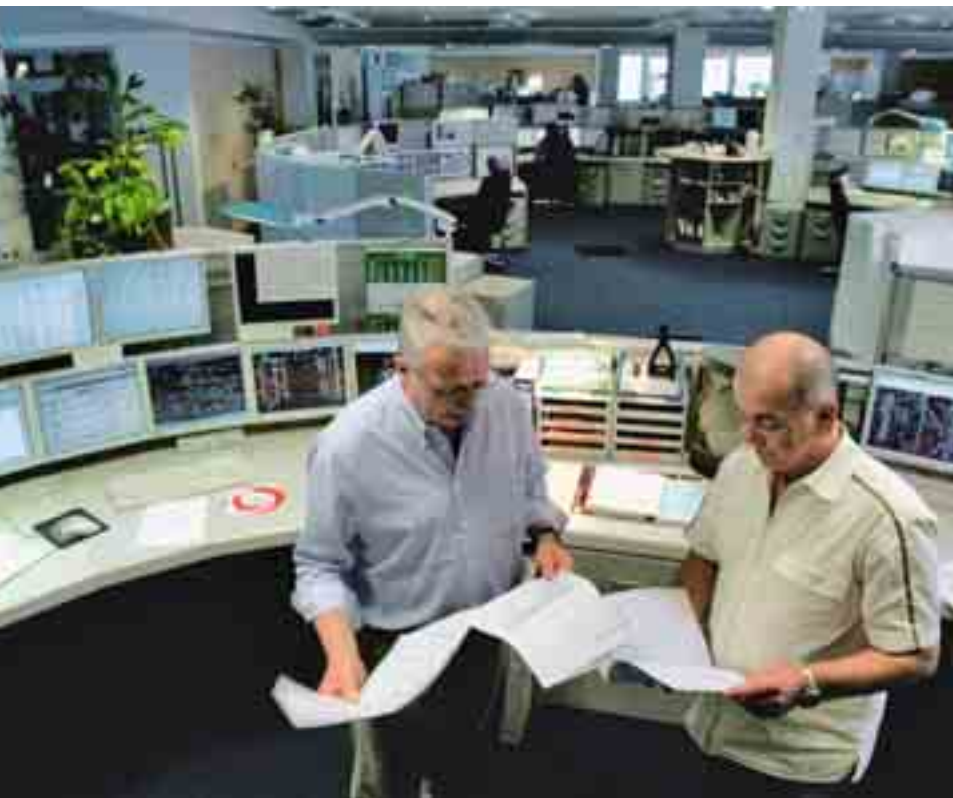
Die Netzleitstelle in Frankfurt am Main
