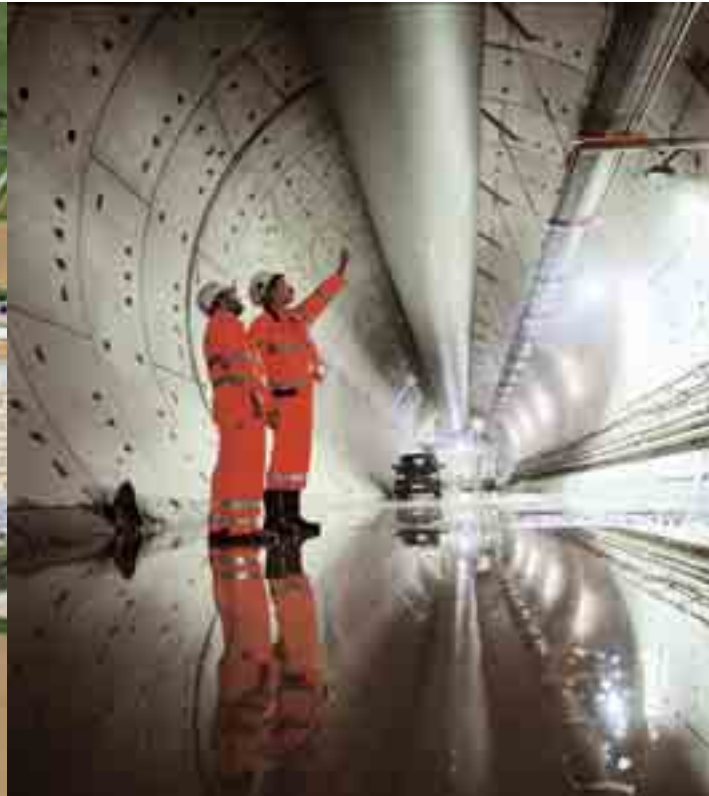
Eine der beiden Tunnelröhren im Rohbau
