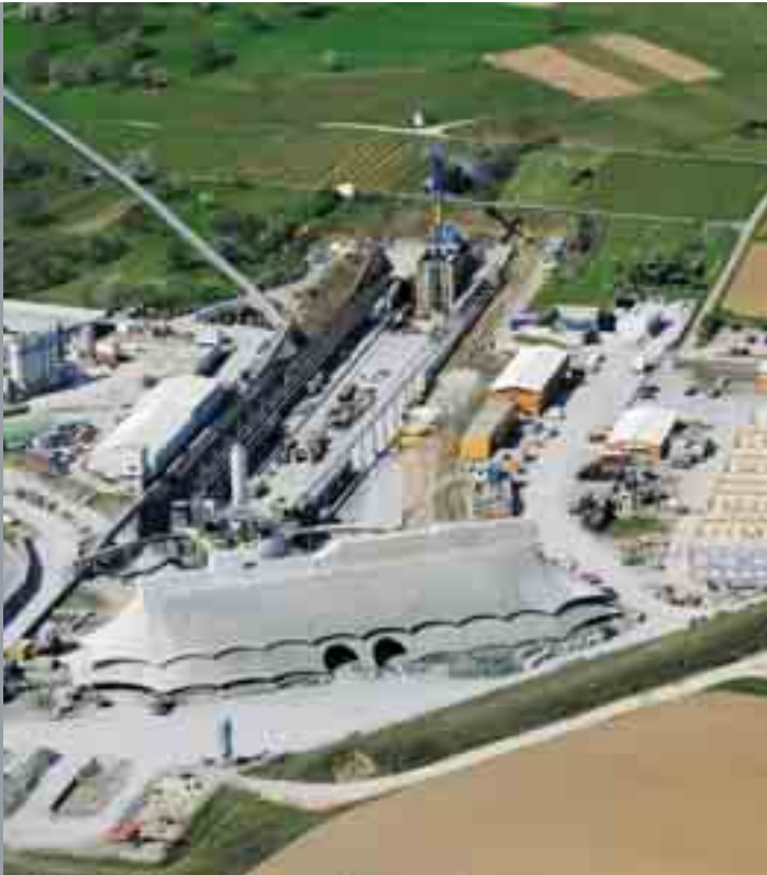
Logistische Meisterleistung: die Baustelleneinrichtung am Südportal des Katzenbergtunnels
