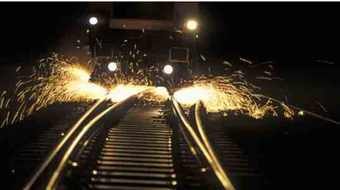
...wie das regelmäßige Schleifen der Schienen
