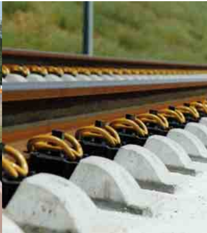
Bei der Festen Fahrbahn liegen die Gleise in einem Bett aus Beton und Stahl
