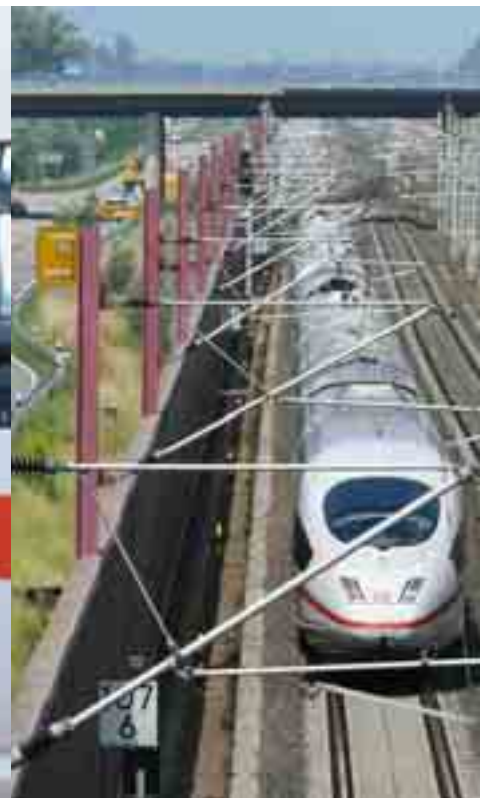
Bereits fertig gestellte Neubaustrecke bei Sinzheim
