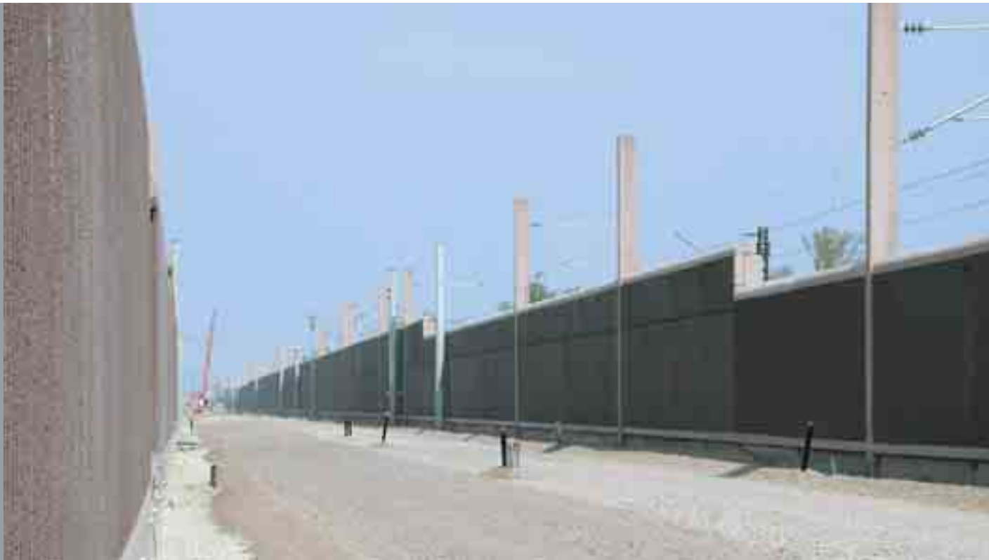
Schallschutzwände reduzieren den Lärm der vorbeifahrenden Züge ebenso ...
