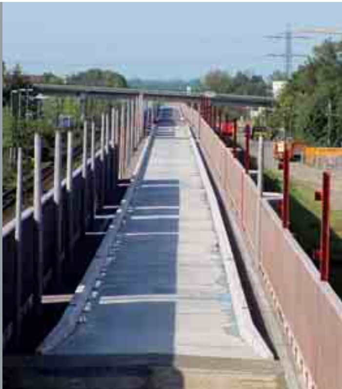
Spezielle Fahrbahnkonstruktion mit Erschütterungsschutz im nördlichen Streckenabschnitt
