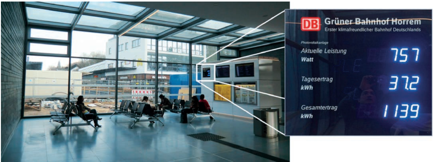
BILD 2: Im Grünen Bahnhof Horrem ist seit Februar 2014 eine Energieuhr angeschossen (Stand: 02/2014; Quelle: DB Station&Service AG, Architekturbüro I.SBP)
