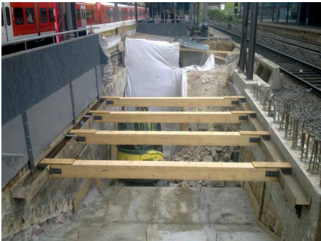
Abb. 15: Bf Mainz Römisches Theater, Bahnsteig 2/3 - Verbreiterung des östlichen Treppenaufgangs und temporäre Kürzung der Bahnsteiglänge Foto: DB Station&Service AG, Frank Höflich
