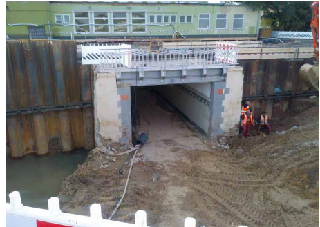
Abb. 11: Bf Bad Kreuznach, Baugrube am Mittelbahnsteig 2/3, Blickrichtung Empfangsgebäude
