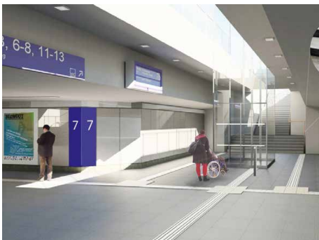
Abb. 4: Taktiles Leitsystem für Blinde und Sehbehinderte in einer Personenunterführung mit Bodenindikatoren, Kontraststreifen an der Aufzugstür und taktiles Handlaufschild (Detail) Foto: DB Station&Service AG, I.SBP Konzeption und Planung
