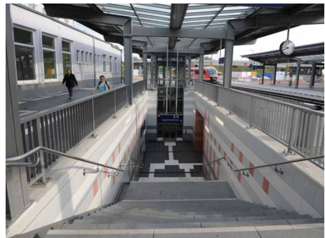
Abb. 12: Bf Bad Kreuznach, Hausbahnsteig 1, Blick auf fertiggestellte Treppe, Aufzug und Anbindung an die Personenunterführung
