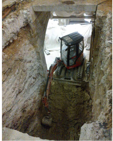
Abb. 14: Bf Mainz-Römisches Theater - Herstellung der Baugrube für einen Aufzug in altem Natursteinmauerwerk Foto: DB Station&Service AG, Frank Höflich
