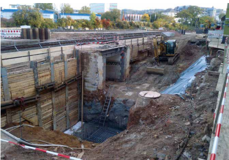
Abb. 10: Bf Bad Kreuznach, Baugrube am Hausbahnsteig, Herstellung des Aufzugsschachtes und des Frontabschlusses der Personenunterführung
