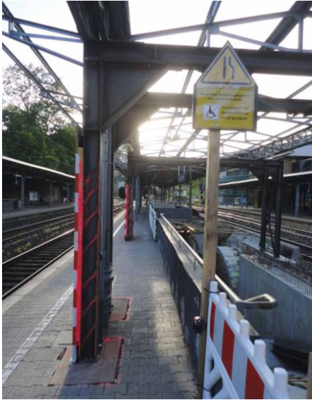
Abb. 16: Bf Mainz Römisches Theater, Bahnsteig 2/3 – Temporäre Engstelle zur Abwicklung des Pendlerverkehrs
