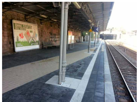
Abb. 17: Bf Mainz Römisches Theater, Bahnsteig Gleis 4, Kennzeichnung der eingeschränkten Durchgänge an den Dachstützen mit Bodenindikatoren
