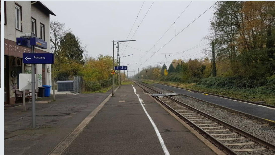
Bahnsteigbereich vor Empfangsgebäude und Mittelbahnsteig (rechts), Blickrichtung Süden
