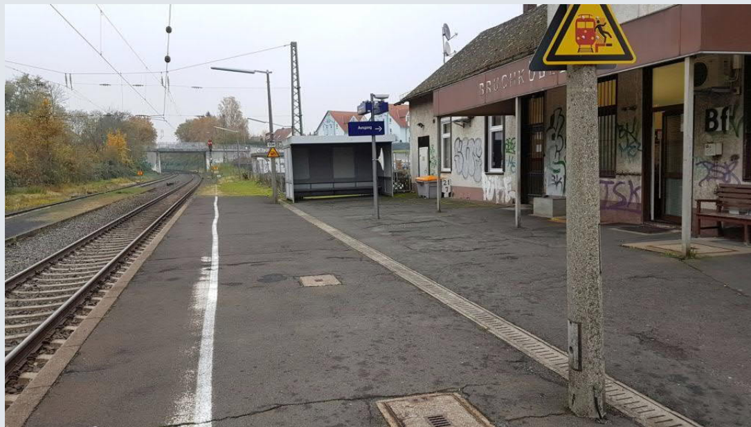
Bahnsteigbereich vor Empfangsgebäude, Blickrichtung Norden
