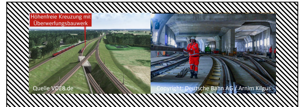
Kombiniertes Verbindungsbauwerk Bahnsteige/Bestandsstrecken
