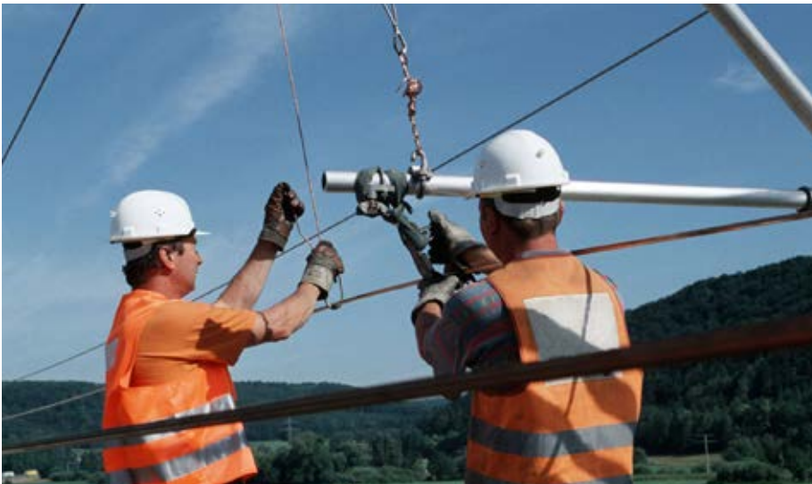
Arbeiten zur Elektrifizierung der Strecke
