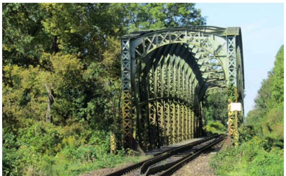
Die bestehende Eisenbahnüberführung über die Argen wird zurückgebaut und komplett erneuert
