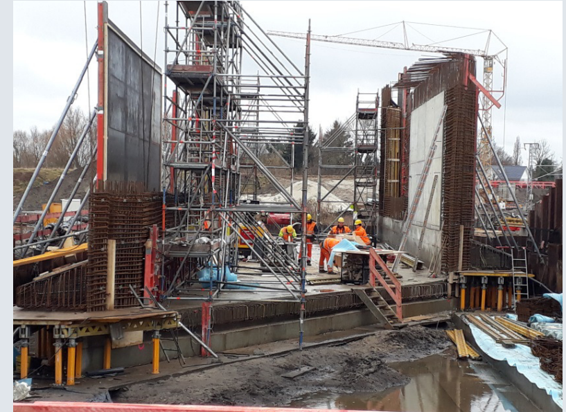
oben: Schalungs- und Bewehrungsarbeiten an den Rahmenwänden auf der F-Bahn-Seite
