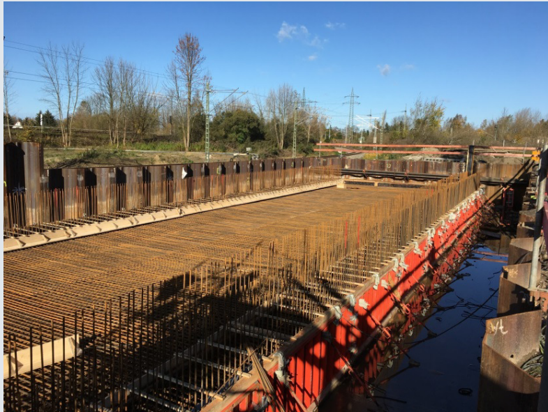
oben: Die Bewehrung der Fundamentplatte S-Bahn-Seit ist eingebaut
