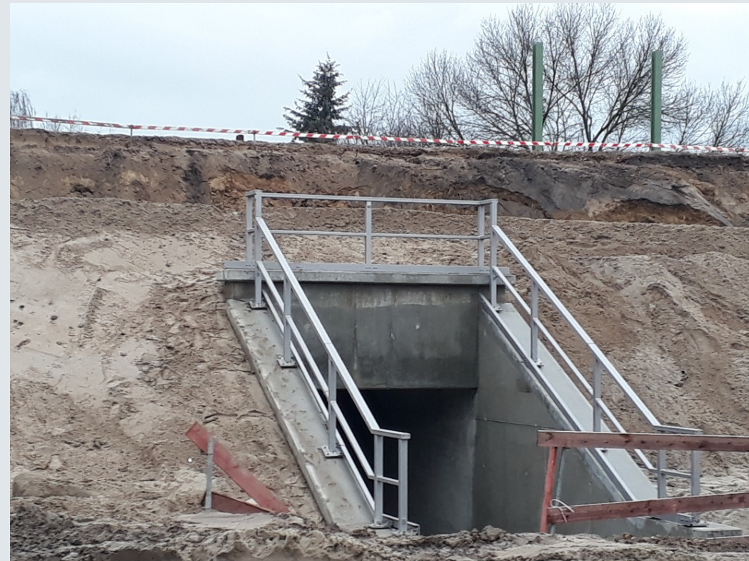
rechts: Die Verlängerung der EÜ Laakegraben für den 2-gleisigen Ausbau der Strecke ist fertig gestellt.
