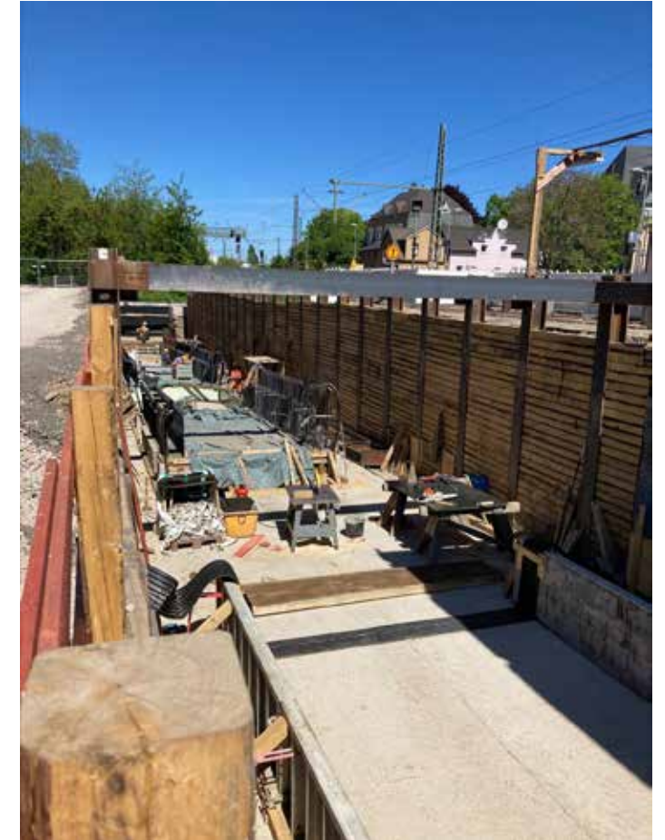
Oberlahnstein: Neubau der Rampe zum Bahnsteig 2
