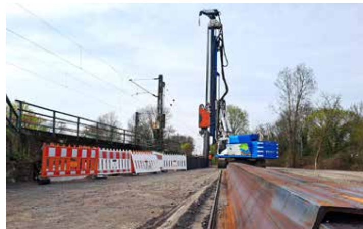
Rüdesheim: Bau des neuen Bahnhofs in - Bohrpfahlgerät
