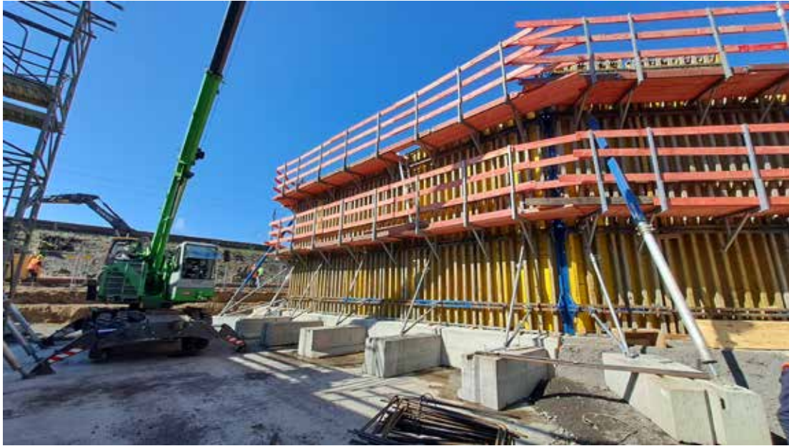
Neuwied: Erneuerung der Eisenbahnüberführung am Schlosspark: Bewehrung der Widerlager
