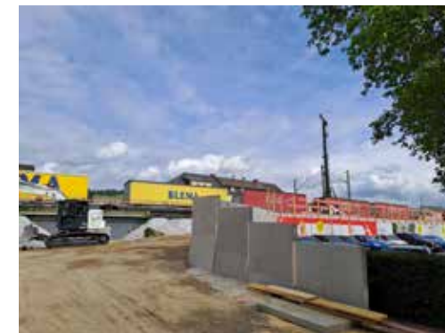
Rüdesheim: Bau der neuen Verkehrsstation
