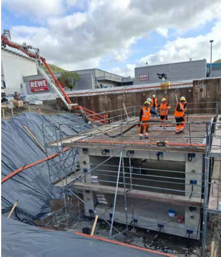
Bad Hönningen: Bau der neuen Personenunterführung
