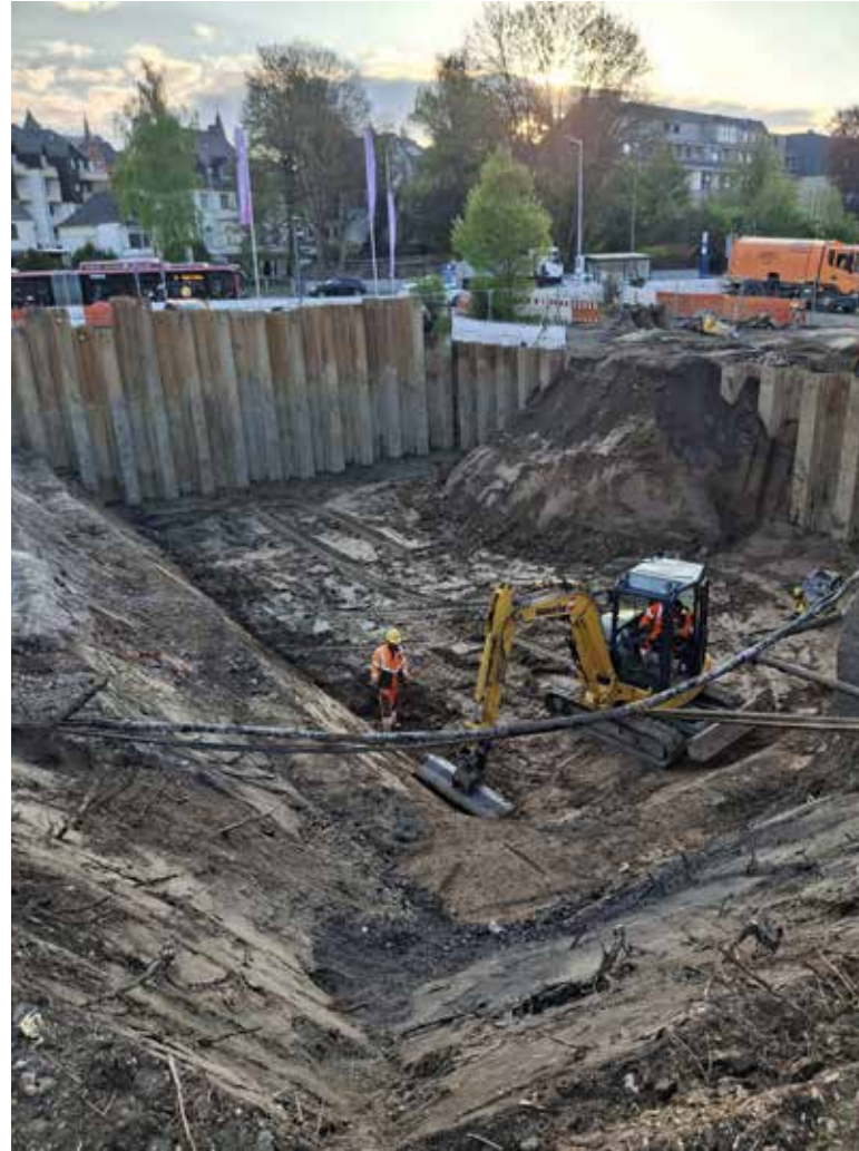
Vallendar: Bau der neuen Personenunterführung
