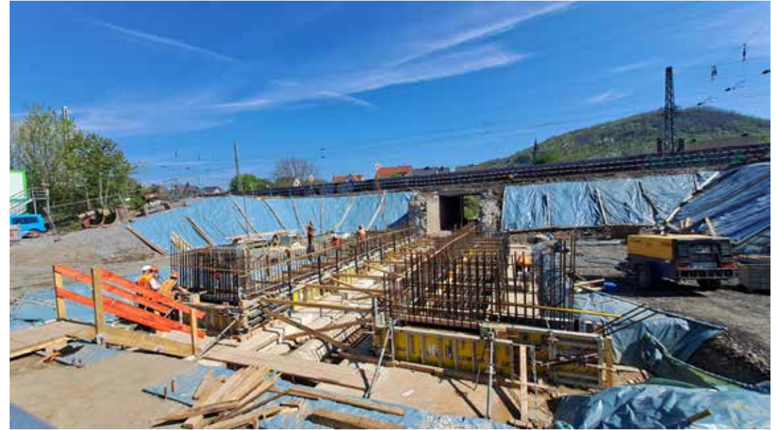
Rheinbrohl: Eisenbahnüberführung Schulstraße. Schal- und Bewehrungsarbeiten
