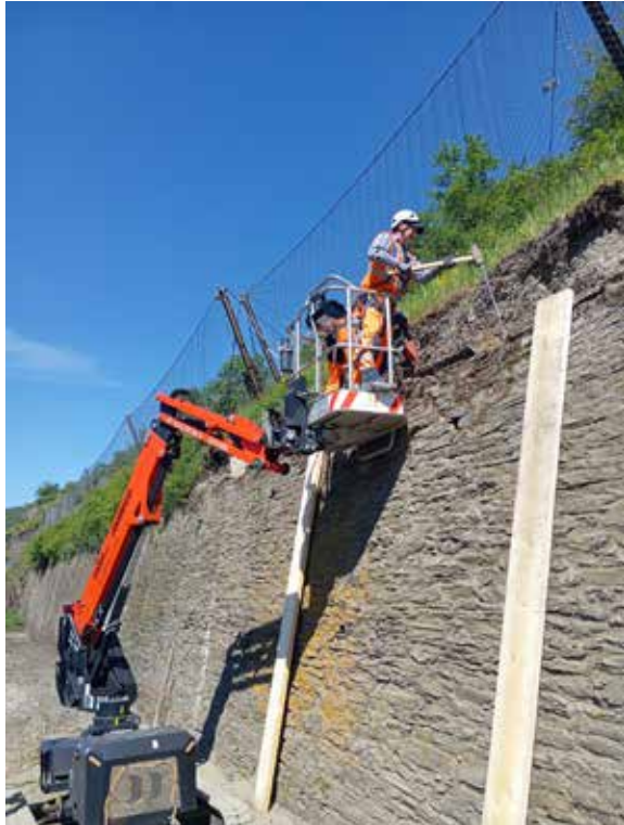
Lorch: Vorbereitende Arbeiten an einer Stützwand
