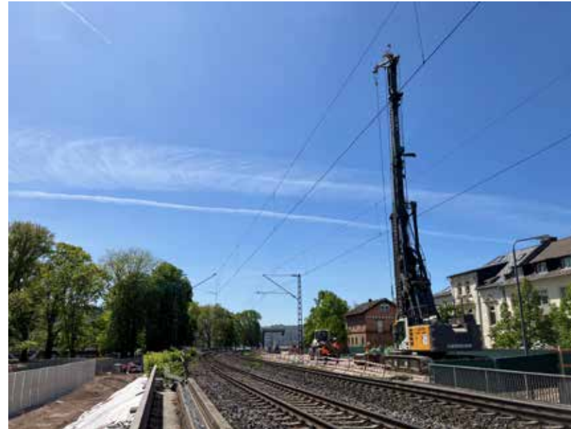
Rüdesheim: Bau des neuen Bahnhofs in - Bohrpfahlgerät
