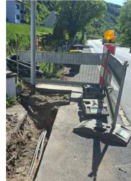
St. Goarshausen: Umverlegung von Gas- und Kabelleitungen am Bahnübergang Blütenweg
