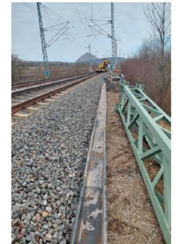
Abb.: Vorbereitung Kabelumverlegungsarbeiten Strecke 6300
