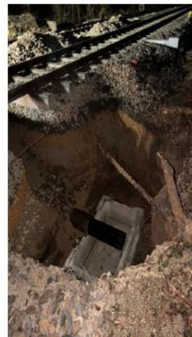
Abb.: Einbau Querung, 6300
