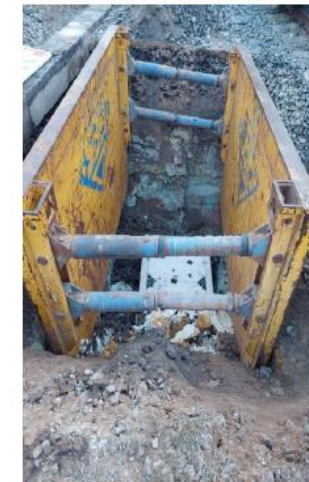
Abb.: Einbau Querung, Strecke 6343
