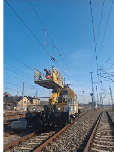
Abb.: Einbau bauzeitlicher Trenner
