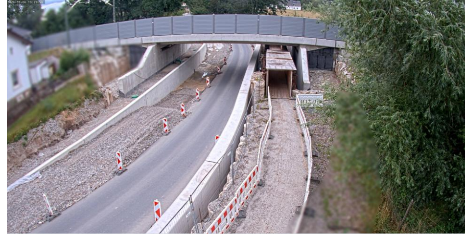
→ EÜ Bahnhofstraße Ponitz (Foto: Bickhardt Bau)
