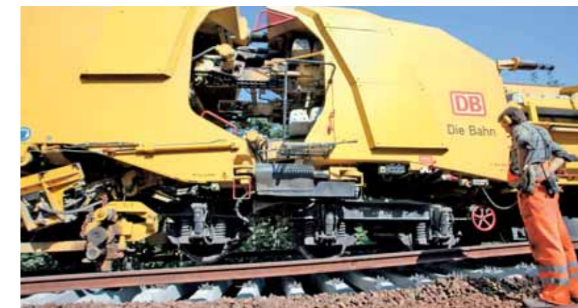
Sanierung und Neubau: Mitarbeiter des Geschäftsfelds Netz verlegen neue Schienenstränge mit einer Gleisbaumaschine.
