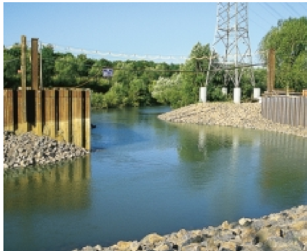
Bauzustand: Vorübergehende naturschonende Umleitung der Sieg an einer Baustelle der Neubaustrecke Köln – Rhein/Main
