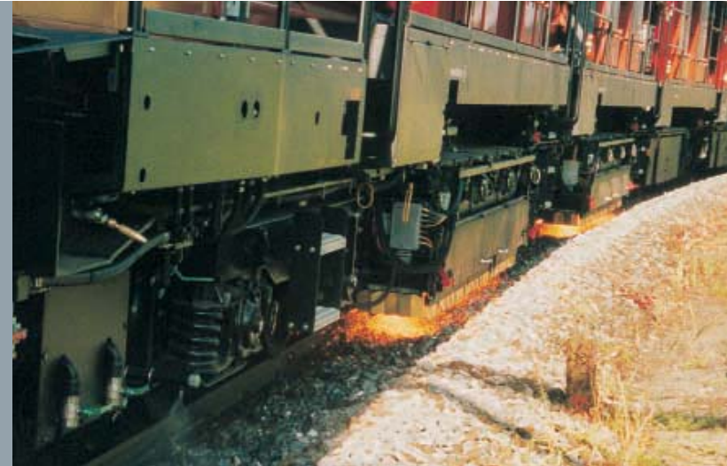
Glatte Gleise sind leise Gleise – Schienenschleifzug im Einsatz.
