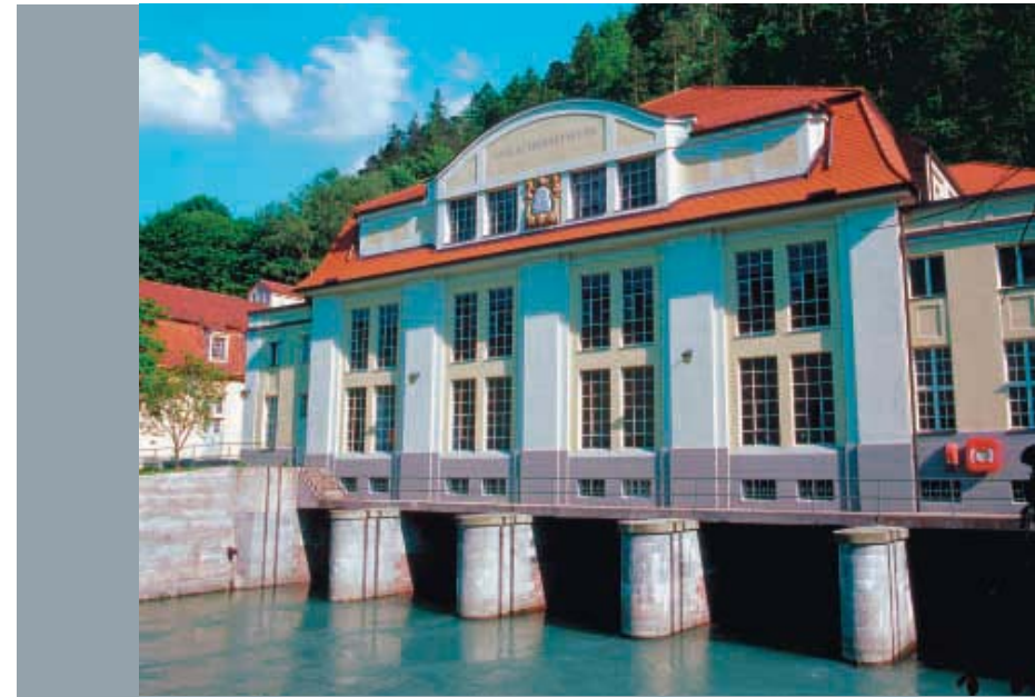
Wasserkraftwerk Bad Reichenhall (Saalbachkraftwerk).
