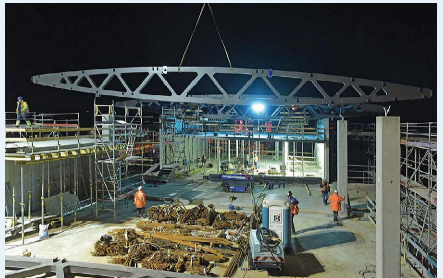
In der nächtlichen Betriebsruhe wurden die bis zu sieben Tonnen schweren Fischbauchträger für das Dach des Empfangsgebäudes montiert.
