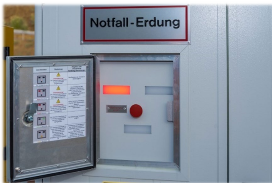
Abbildung 12: Leuchtmelder und Nottaster einer OLSP
