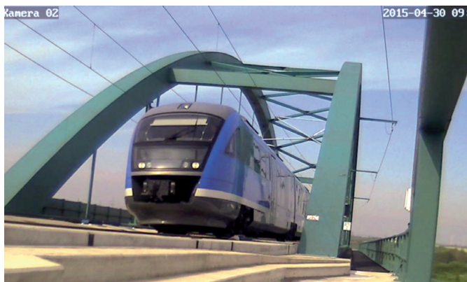
ETCS-Testfahrt auf der Saale-Elster-Talbrücke
