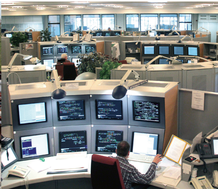
ESTW-Betriebszentrale in Leipzig
