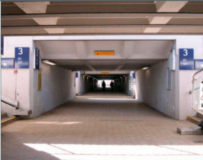
BILD 7: Unterführung Garmisch-Partenkirchen vor dem Umbau
