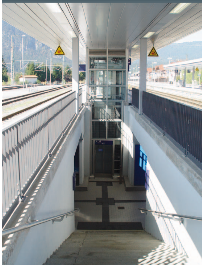
BILD 5: Mittelbahnsteig Garmisch-Partenkirchen mit Aufzug und saniertem Dach, Stand 02/2011
