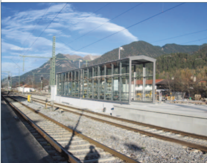
BILD 11: Treppeneinhausung zur neuen Unterführung in Mittenwald
