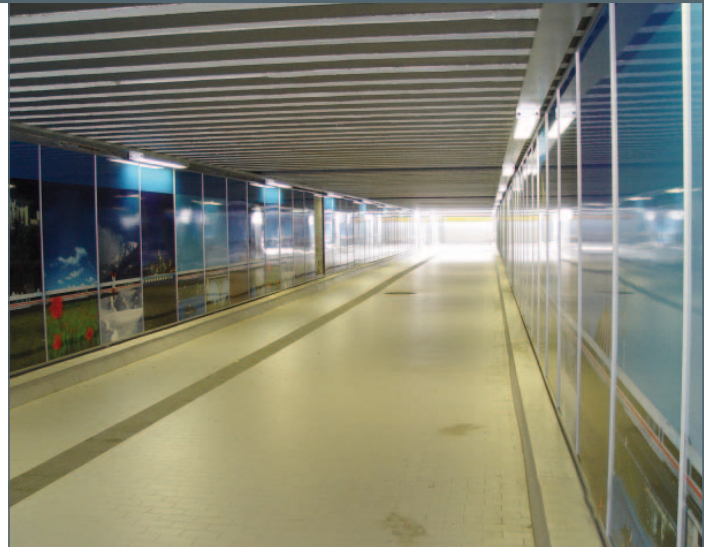
BILD 8: Unterführung Garmisch-Partenkirchen nach dem Umbau
