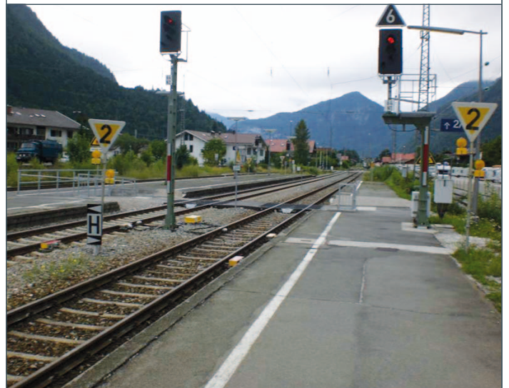
BILD 10: Ehemaliger Überweg am Bahnsteigende in Mittenwald
