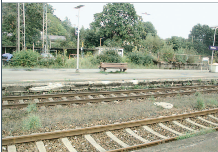
BILD 1: Murnau – Bahnsteigsituation vor dem Umbau
