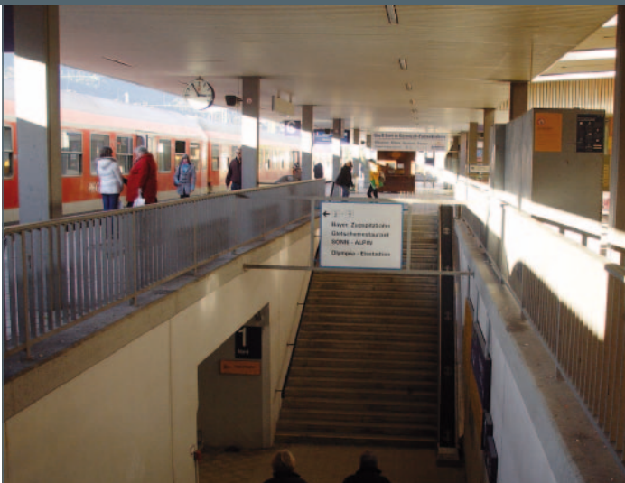
BILD 3: Mittelbahnsteig Garmisch-Partenkirchen mit Treppenzugang Stand 2009
