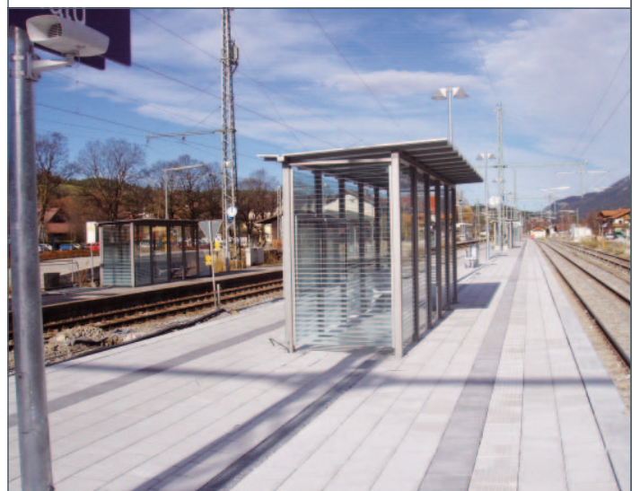
BILD 12: Bahnsteig in Mittenwald mit Blindenleitsystem und Wetterschutzanlage
