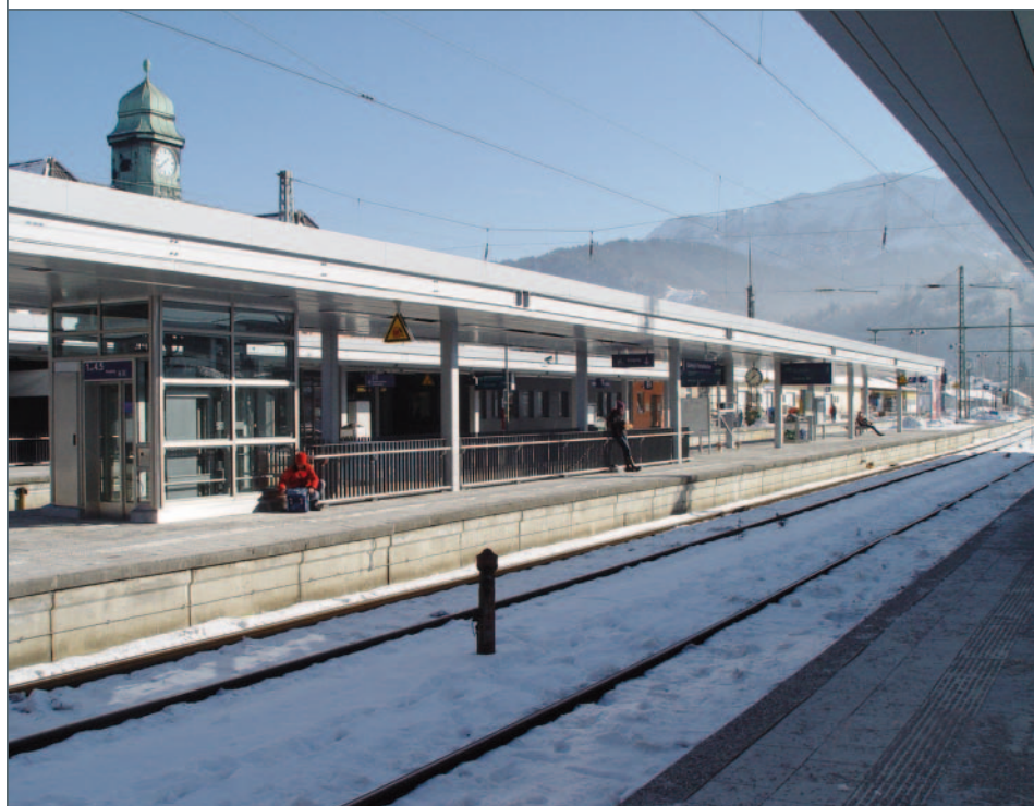
BILD 6: Mittelbahnsteig Garmisch-Partenkirchen nach der Sanierung
