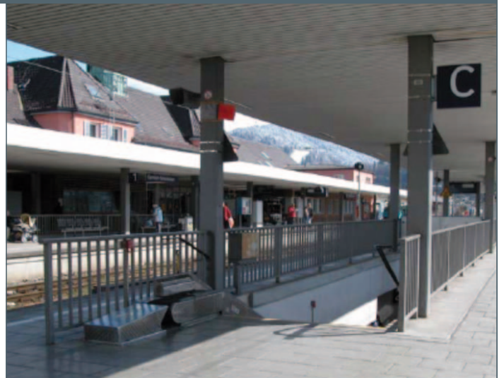
BILD 4: Mittelbahnsteig Garmisch-Partenkirchen Stand 2009
