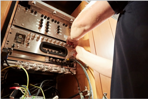
Einbau des zentralen Servers des WLAN-Systems
