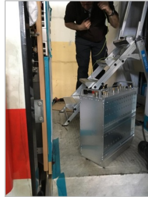
Einbau eines neuen Mobilfunkrepeaters
