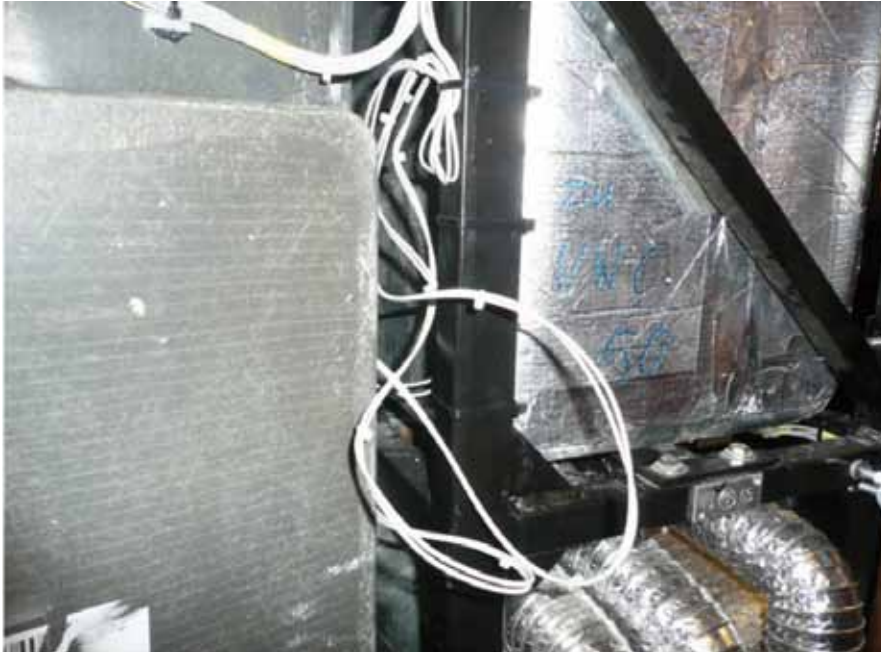
B13 ÜG_ KABELVERLEGUNG _mangelhafte Leitungsbefestigung
