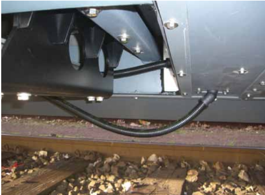
B5 ÜG_KABELVERLEGUNG_elektrische Leitung ragt ins Profil
