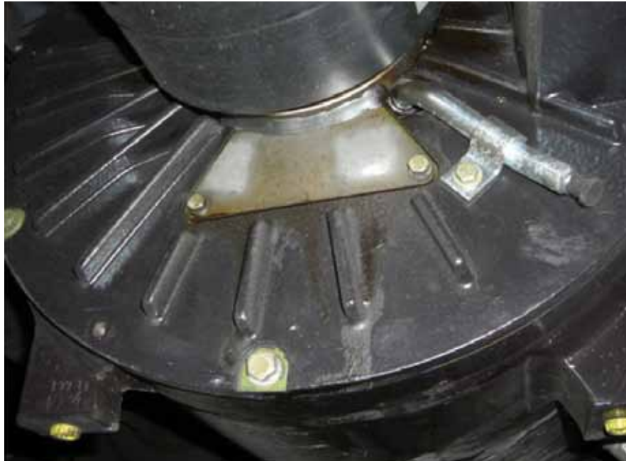
B19 ÜG_ROHR_DICHT_Undichtigkeit am Getriebe_1
