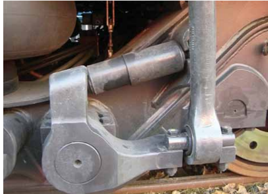
B8 ÜG _ROHR_DICHT _Dämpfer undicht
