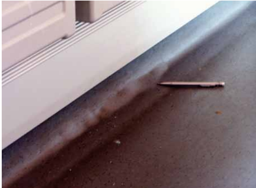
B7 INNENAUSTATTUNG _Fussboden beschädigt u. blasig
