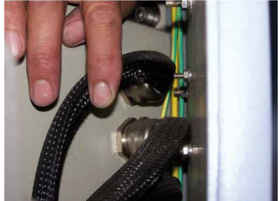
B4 ÜG_KABELVERLEGUNG_E-Leitung liegt an
