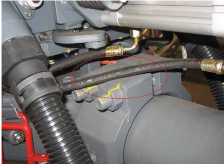
B11 DREHGESTELL_Luftschlauch scheuert
