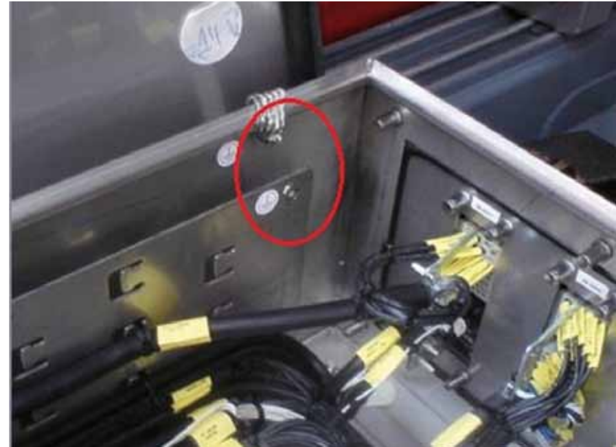
B6 ÜG_ERDUNG_Erdung nicht angeschlossen
