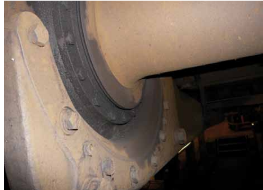
B20 ÜG_ROHR DICHT_Undichtigkeit am Getriebe_2
