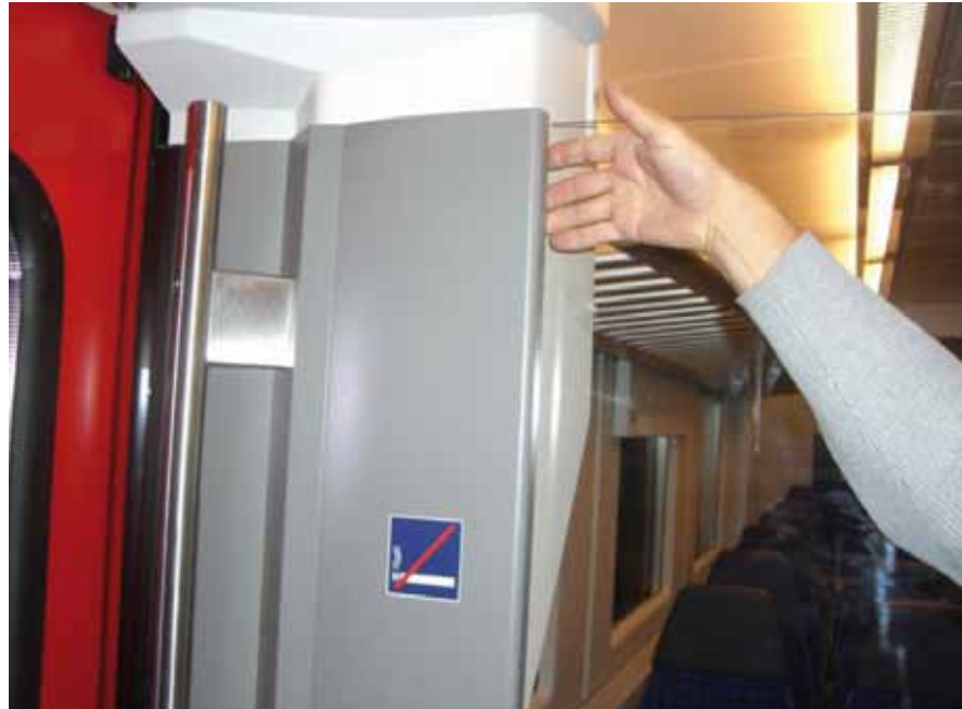
B15 ÜG_MONTAGE_Spalt an Verkleidungselement
