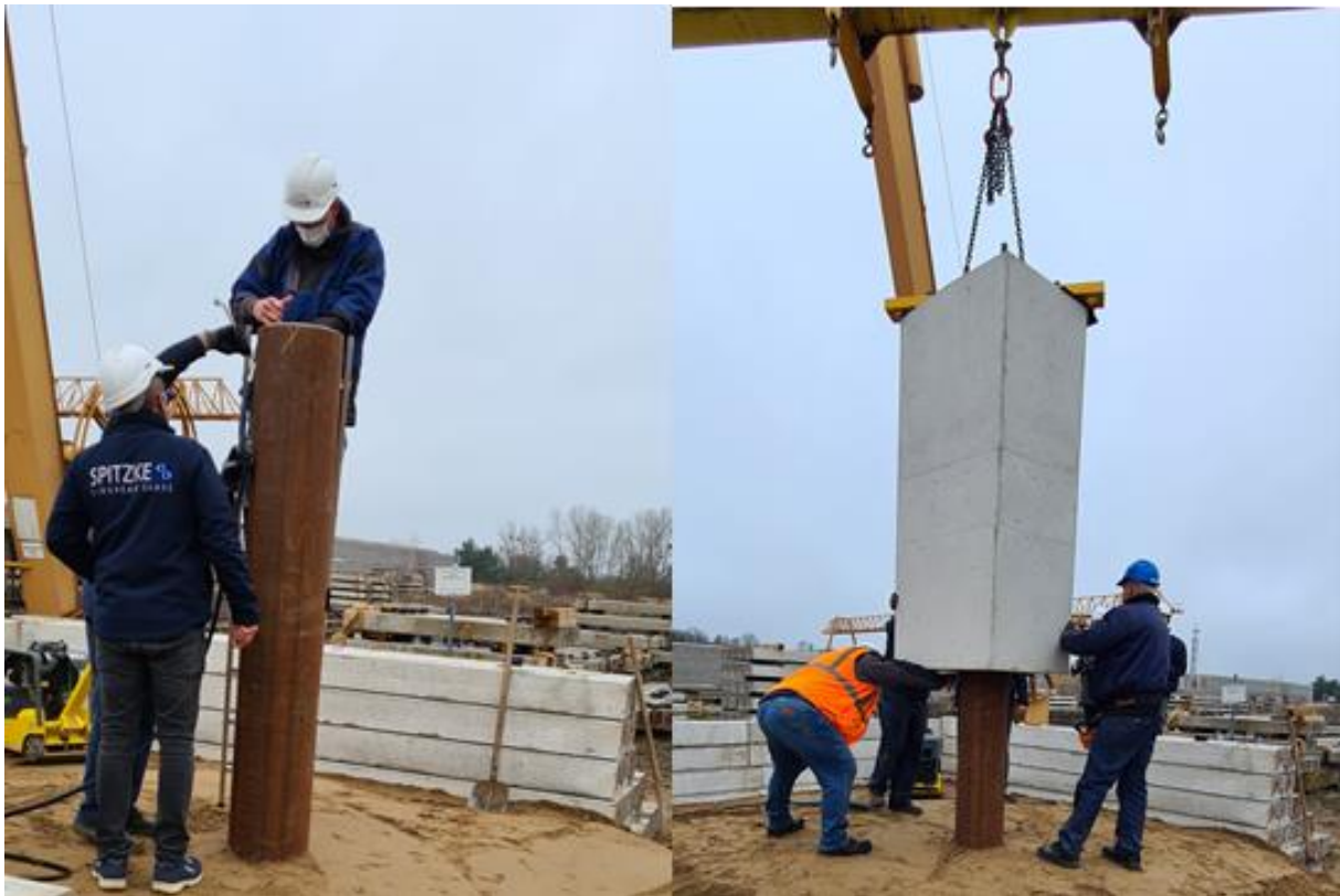
Einbauversuch Fertigteilfundamentkopf Möllenhagen 11/2021
