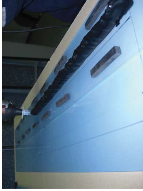
Bild 2: Aufbringen Klebstoffraupe
