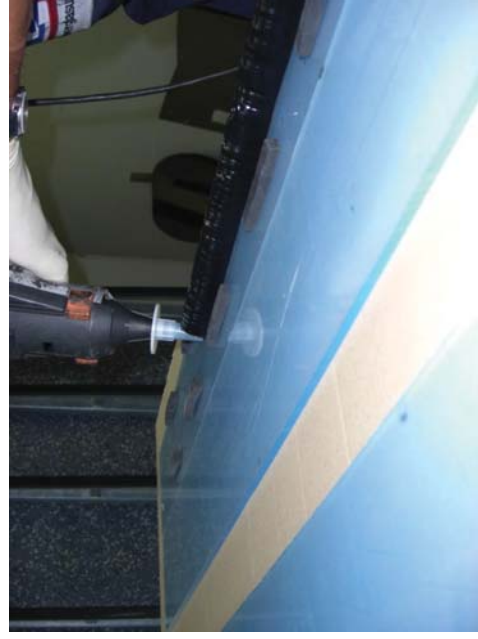
Bild 3: Aufbringen Klebstoffraupe
